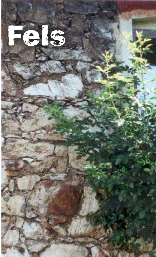
Hausmauer Erzgasse 4, Neuberg an der Mürz: Bruchsteinmauerwerk (um 1800) aus Erzführendem Kalk (hell) und Eisenerz (braun). Das Material wurde im Bereich der Erzsteinwand gebrochen.
